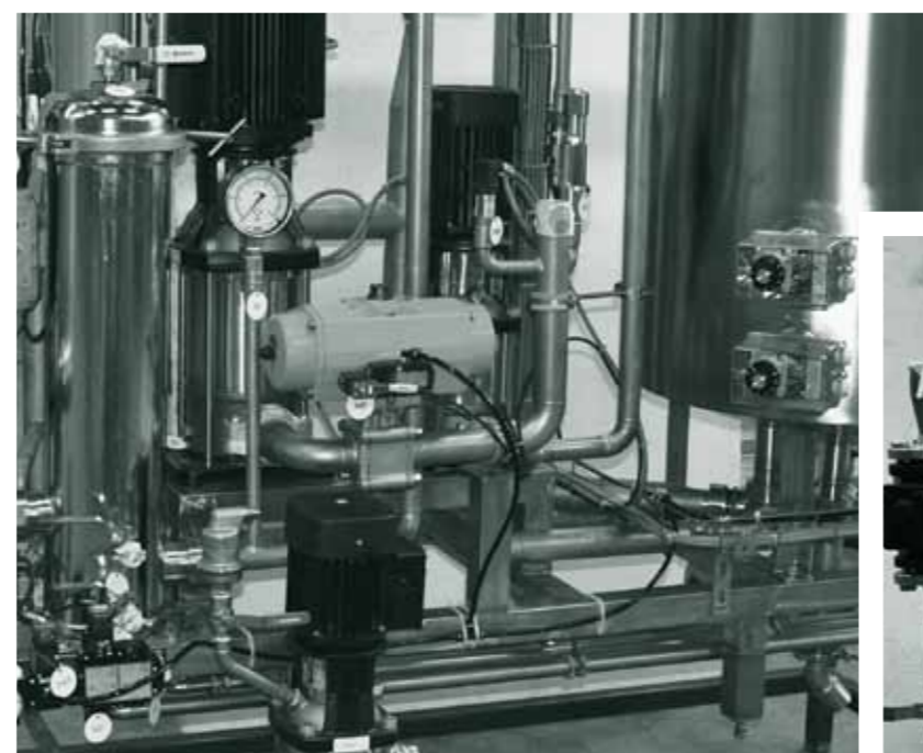
Toppvattnekrets Rack för pumpning och filtrering av tempererad fluid i samband med pressar.
