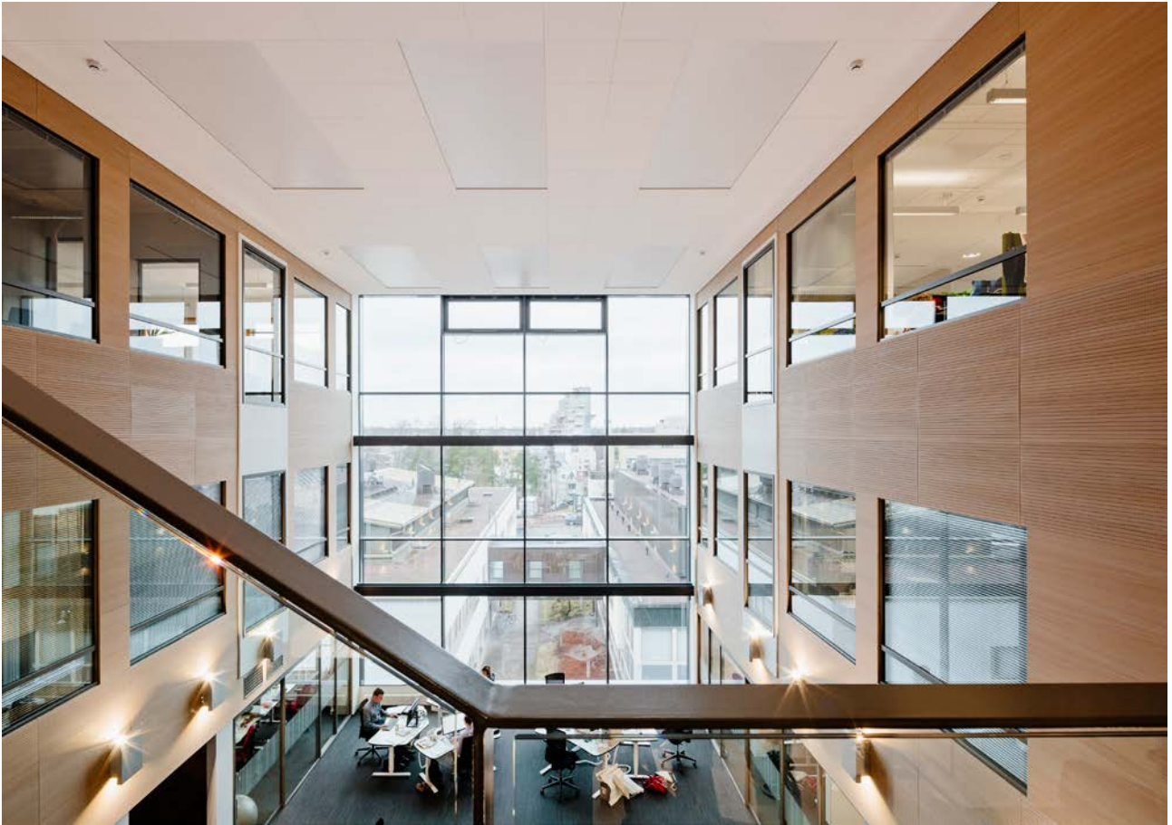
Tyylikkääät Frenger kattosäteilijät sulautuvat hyvin moderniin toimistorakennukseen, THL päärakennus
