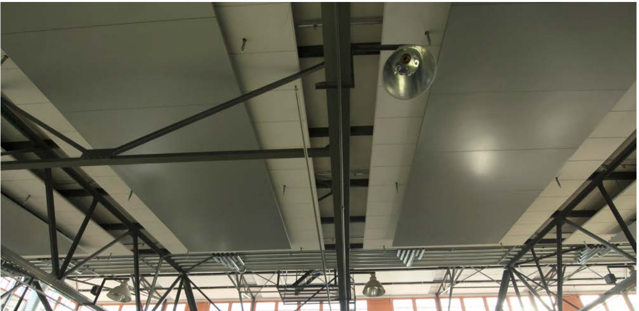
Amer Sports Oy:n uusi pääkonttori Vallila Helsinki. Säteilijät ryhmitelty lautoiksi.
