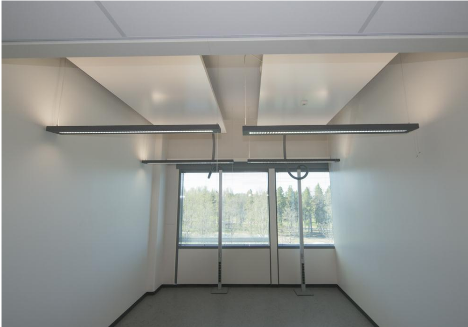
Frenger alumiinirakenteinen säteilijä, Tiedepuisto Joensuu
