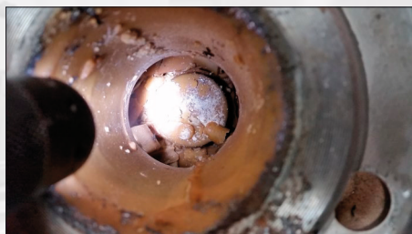
Før udsyring af VV-rørvekslere
